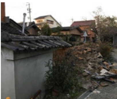
河川の氾濫により、崩れてしまった土壁
